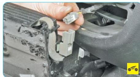
39. Отожмите фиксатор и разъедините колодки жгута проводов освещения вещевого ящика.
